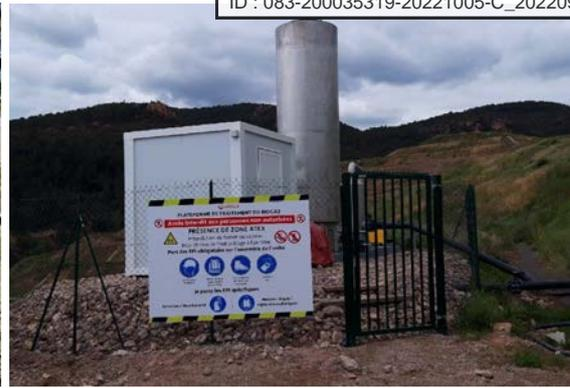
Les biogaz produits par les déchets sont collectés pour alimenter en énergie la chaudière de l'évapoconcentrateur (mode de traitement des lixiviats). Lorsque ce dernier ne fonctionne pas, la torchère permet de brûler le biogaz. En 2021 l'ancienne torchère de 2 000 m<sup>3</sup>/h a été remplacée par une 400 m<sup>3</sup>/h, plus adaptée au besoin du site. Elle est installée à proximité des stations de traitements des lixiviats afin de regrouper tous les process sur un même secteur.
