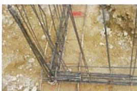
Nœud de chaînage - Continuité mécanique
